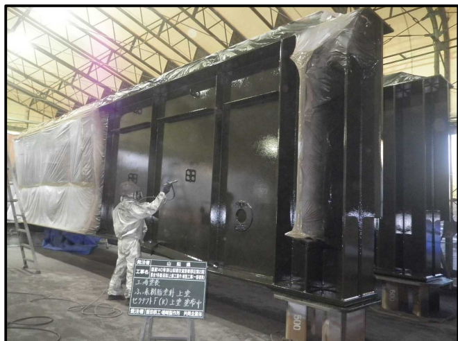
施工状況(桁端部塗装)
