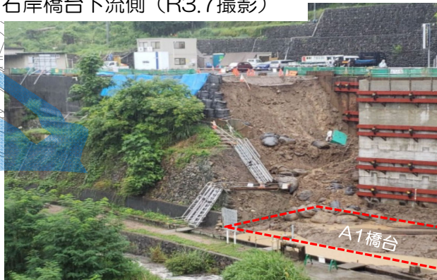
令和3年7月の降雨により、掘削面が崩れた様子
