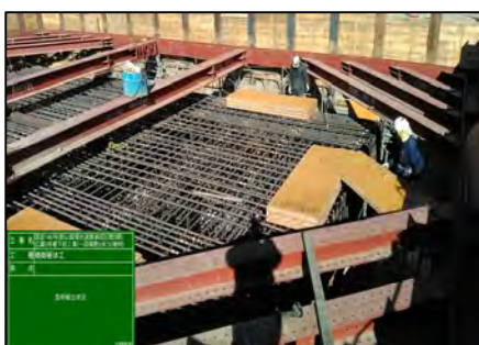
型枠設置状況
