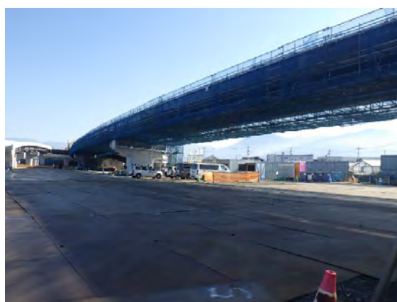
鋼桁架設完了
