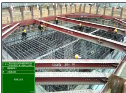
鉄筋設置状況
