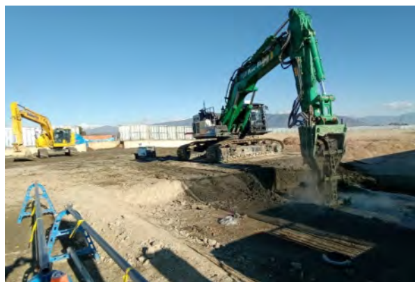
地盤改良施工状況（パワーブレンダー工法）
