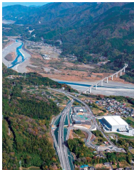
開通した中部横断自動車道
