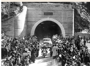
新世子トンネル開通
