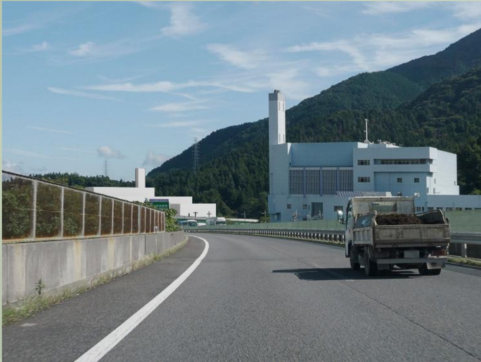
煙突高さ59m
