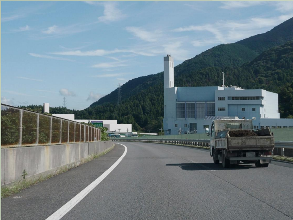
煙突高さ59m
