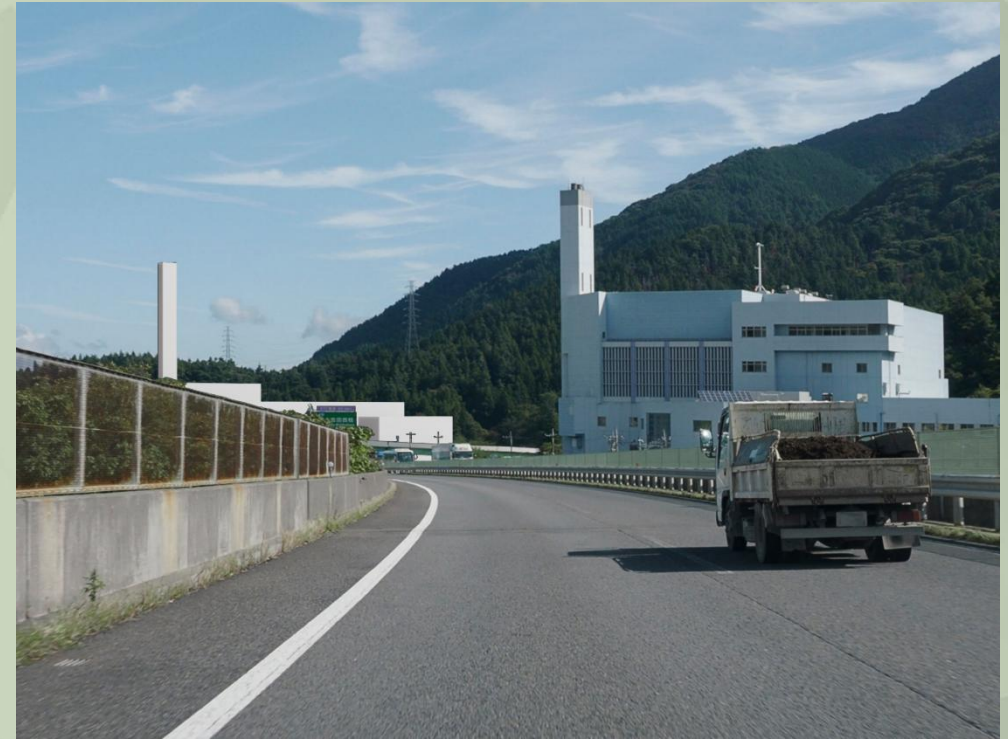
煙突高さ100m
