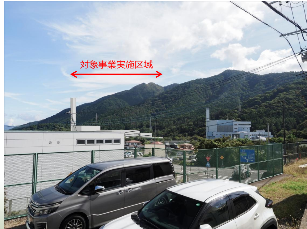
煙突高さ100m
