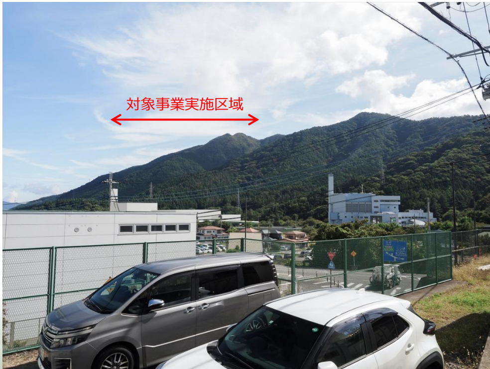
煙突高さ59m
