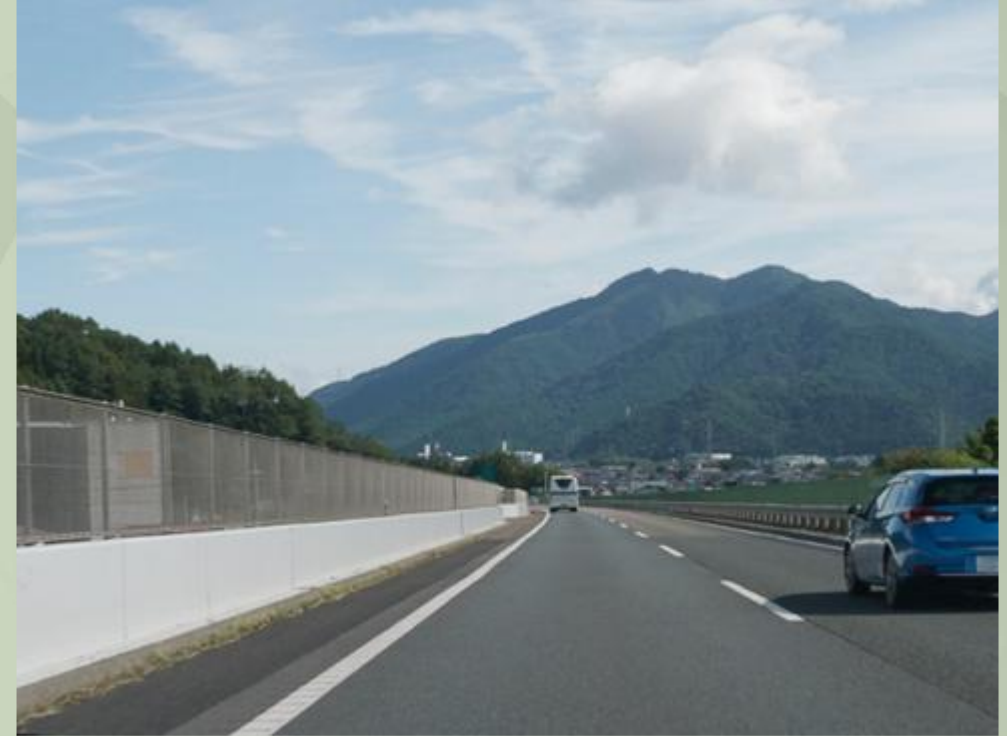
景観No.4-② 中央自動車道富士吉田線（上り線） （煙突高さ59m）
