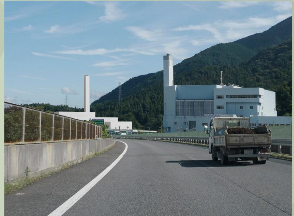
煙突高さ100m
