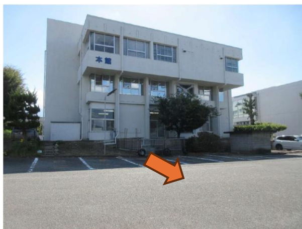
保管場所入り口と駐車場
