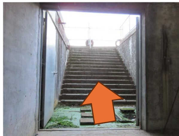
保管場所から駐車場
