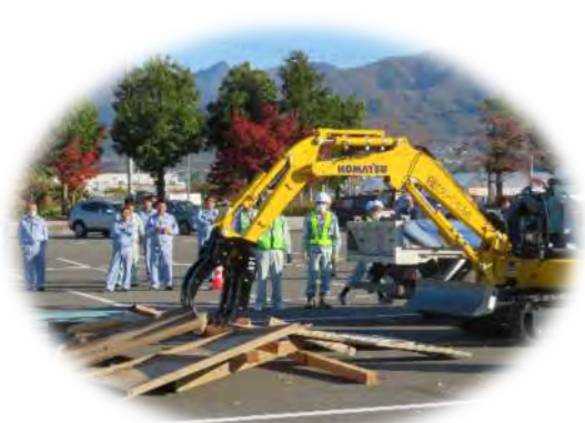
瓦礫撤去状況
