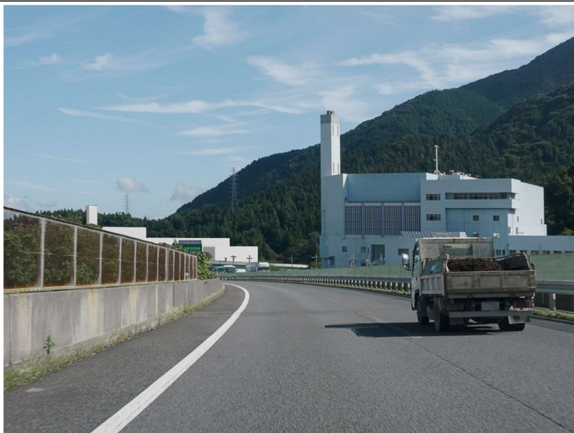
既存施設撤去前 展葉期 煙突高さ 59m
