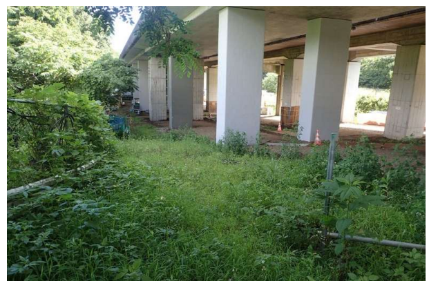
高架橋下部（西側より）
