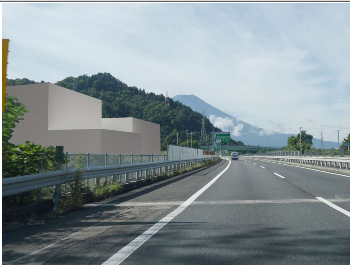
既存施設撤去後 展葉期 煙突高さ 59m
