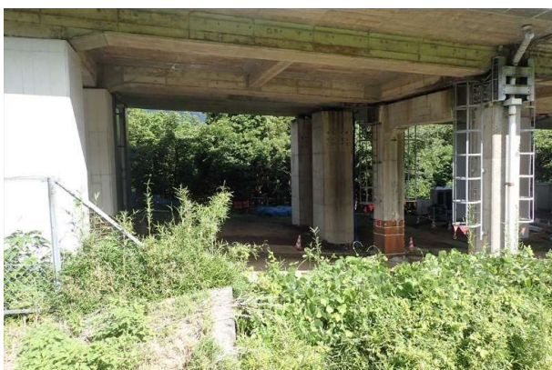
高架橋下部（東側より）
