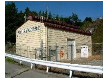
小屋敷第二発電所
