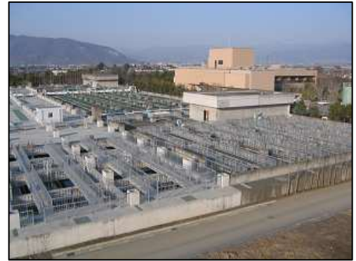
下水道施設 (峡東浄化センター)
