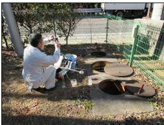
浄化槽法定検査
