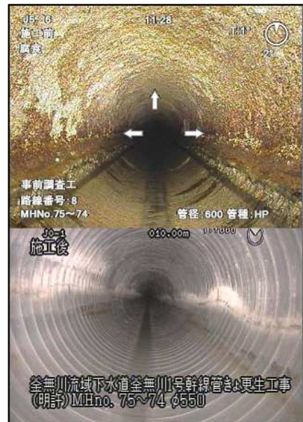
管きょ更生工事 上（更生前）下（更生後）
