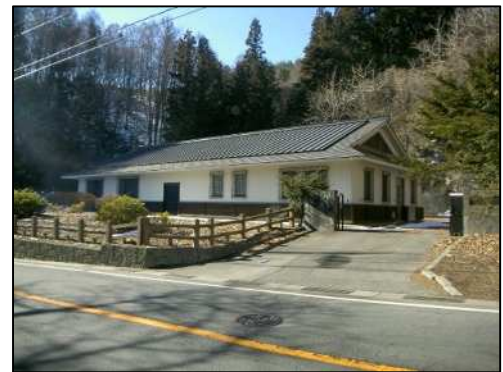
農業集落排水処理施設 ( 北杜市高根町長沢 )
