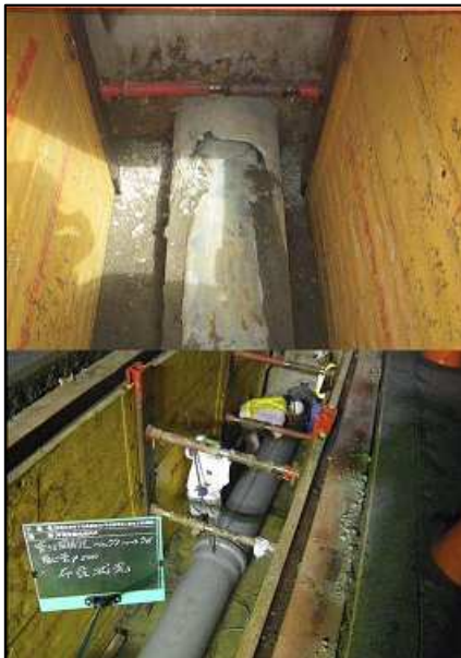
管きょ改築（更新）工事 上（更新前）下（更新後）
