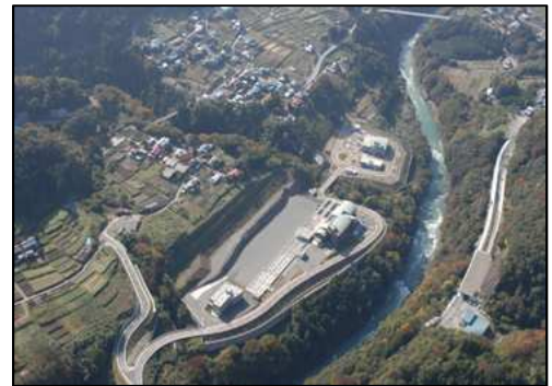
下水道施設 ( 桂川清流センター )
