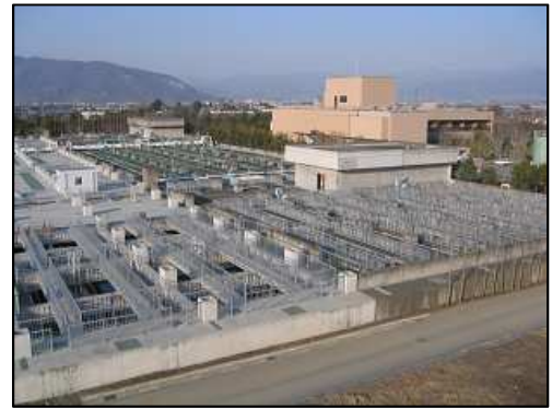
下水道施設 ( 峡東浄化センター )
