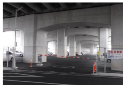
新山梨環状道路の高架下
