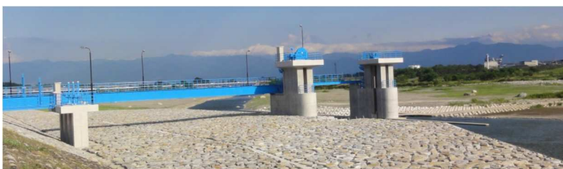
頭首工（農業用水利施設）
