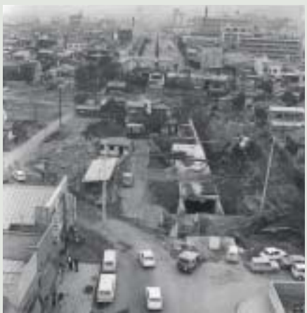
昭和40年代、南へ延長された「新々平和通り」との最後のドッキング作業工事。(写真上方が甲府駅方面)
