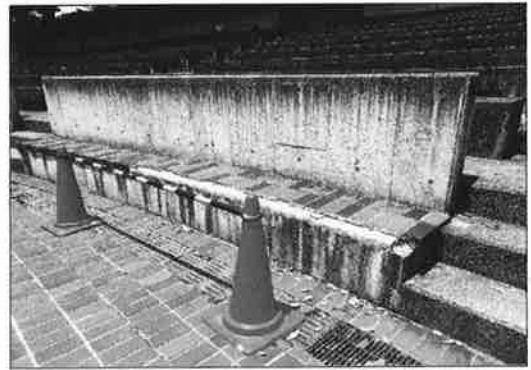
現場にコーンバーを設置し安全確保
