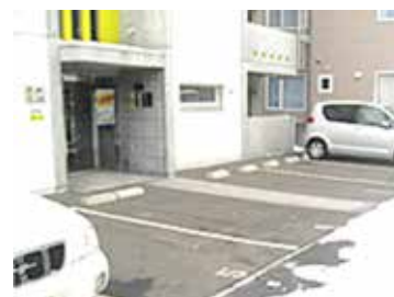
マンション駐車場への導入事例
