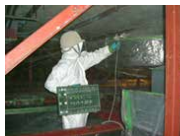
アスベスト封じ込め施工
