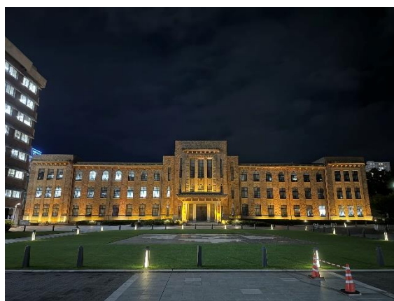
県庁別館ライトアップの様子
