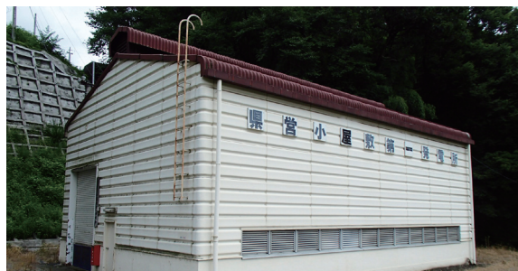
小屋敷第一発電所
