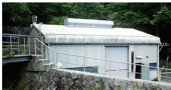
琴川第二発電所
