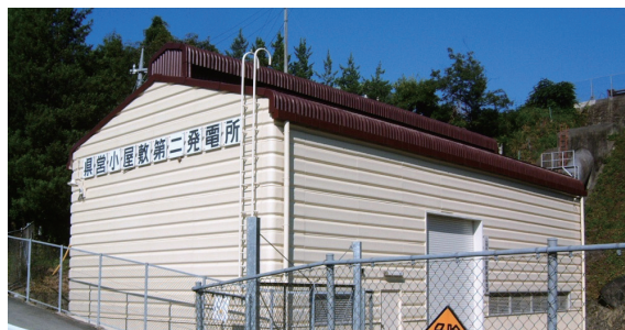
小屋敷第二発電所
