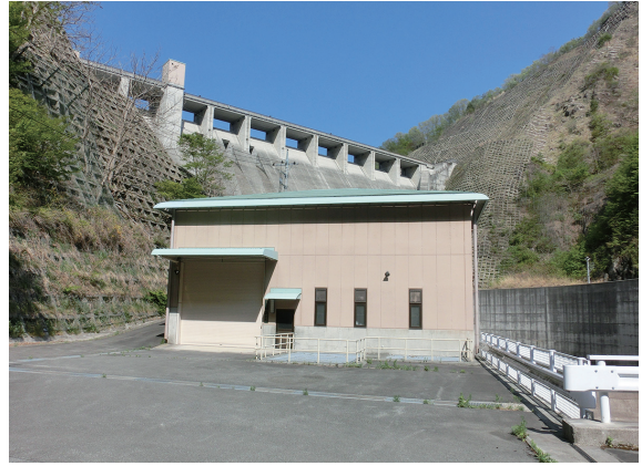
塩川発電所全景
