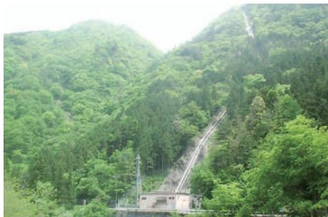
湯島発電所は、西山発電所建設時に調査計画が進められた経過がありますが、昭和48年の石油事情の悪化とコスト高により国内循環資源でクリーンな水力が再認識され、昭和54年度から調査を行い、計画の成案を得て昭和56年度に建設を開始し、昭和58年4月から営業運転に入りました。支流の仙城沢川の高落差で安定した水源を利用するものであり、仙城沢川上流部に取水えん堤を設けて最大0.72m<sup>3</sup>/sの取水を行い、延長480mの導水路トンネル及び550mの水圧鉄管により343.5mの落差を得て最大2,000kWの発電を行っています。
