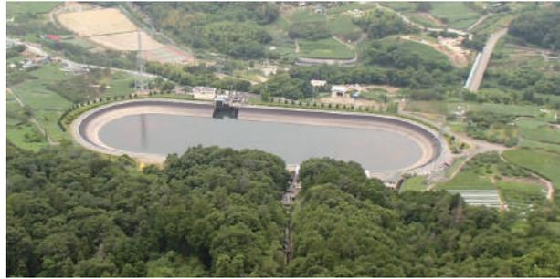
笛吹川水系発電所管内で最大の規模をもつ発電所です。広瀬ダムの貯留水の放流を利用し、上流の広瀬、天科両発電所とともに、ピーク運転を行っています。
