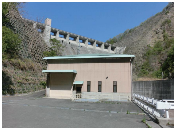
塩川発電所全景
