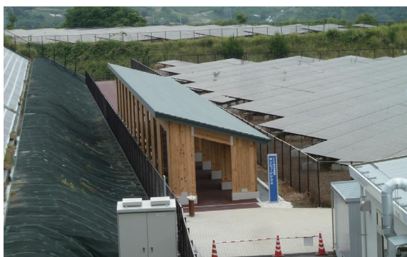
サンシェードテラス（CLT屋外休憩施設）
