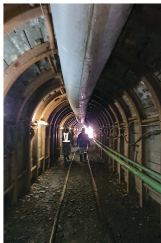
保川発電所導水路トンネル
