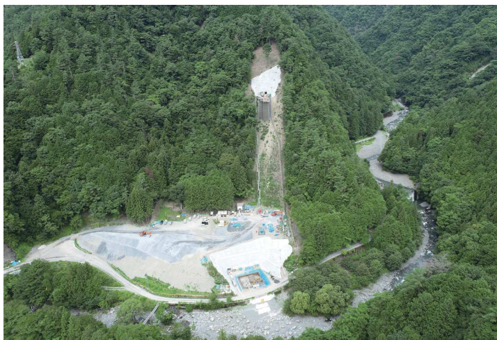
保川発電所建設中
