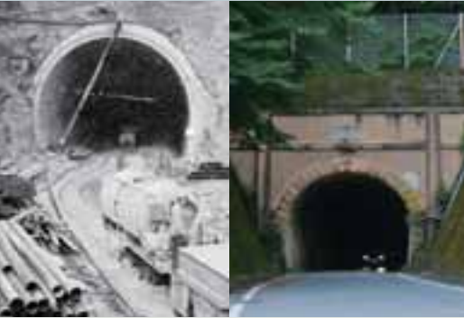
旧御坂隧道の工事風景。現在は登録文化財に指定されている。抗門には「天下第一」の銘文が。
