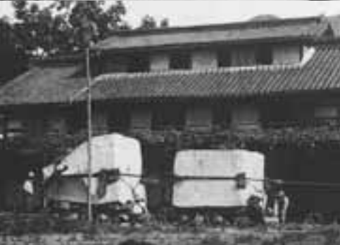
謝恩碑の石材はコ口を使って運んだ。左側の三角の石材は碑の先端部分である。
