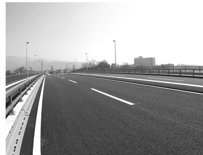
甲府駅北口へと延びる都市計画道路 愛宕町下条線
