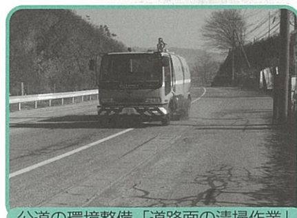
公道の環境整備「道路面の清掃作業」
