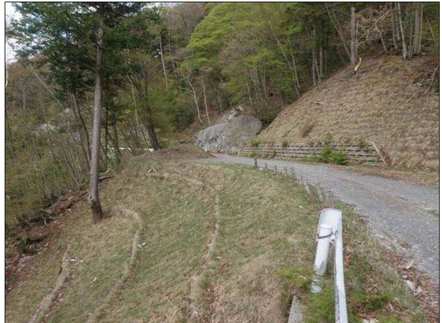
完了区間の間伐材利用状況（丸太柵工）
