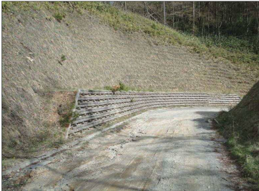
完了区間の間伐材利用状況（木製土留工）
