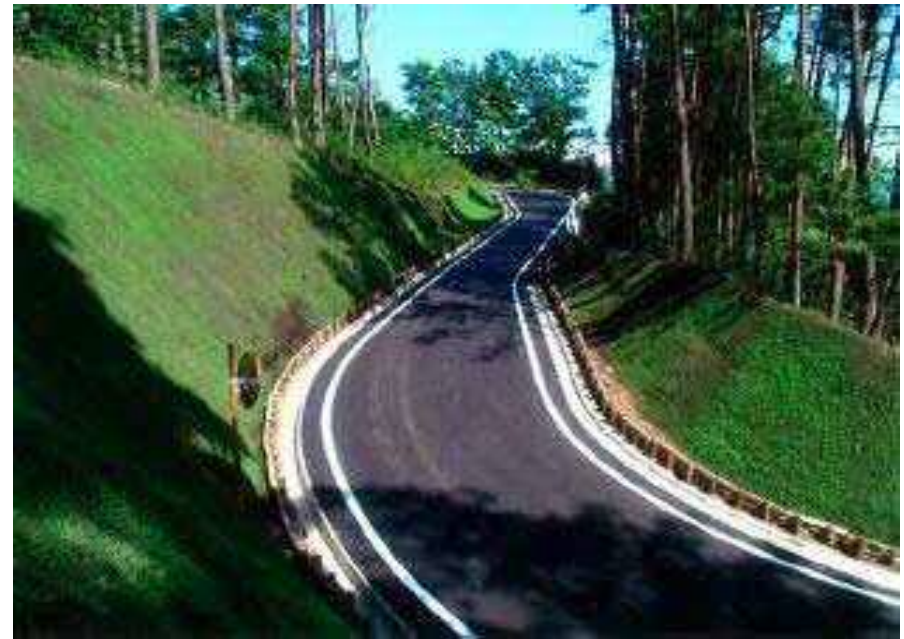
完成区間の状況
