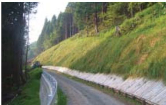
写真1. 厚層基材吹付工施工のり面
