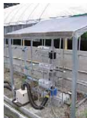
写真2 堆肥舎に設置した三連のセラミック電気管状炉-金属酸化触媒式分解装置
