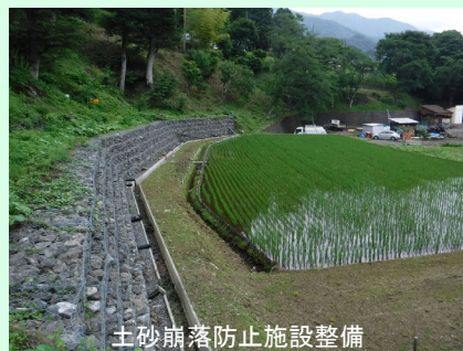
土砂崩落防止施設整備
