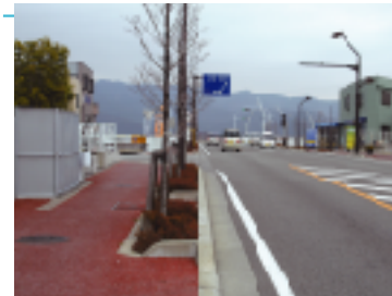
電線類の地中化が進む県道
