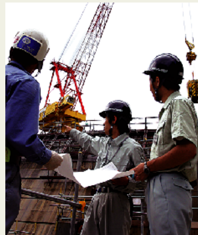
ダム建設工事(広瀬・琴川ダム事務所)
