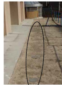
非常時にトイレとして使用できるマンホールトイレ
