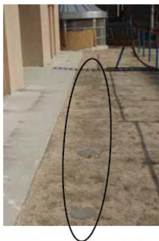
非常時にトイレとして使用できるマンホールトイレ
