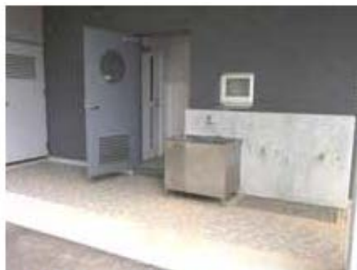
外部から利用できるトイレ
