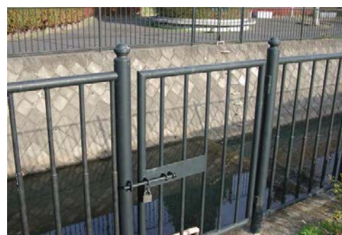
開閉式フェンスの設置(町田市)
