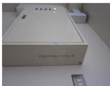
電源の自動切替え機能を持ち、下部から電源の取り出しができる電源切替盤
