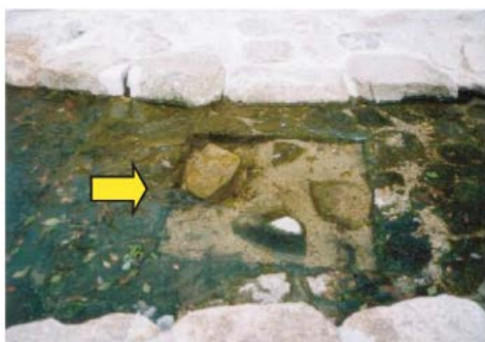
取水ピットの整備
