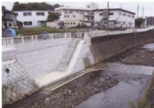
階段に取水用ピットを設置し、消防水利に活用 (横浜市)
