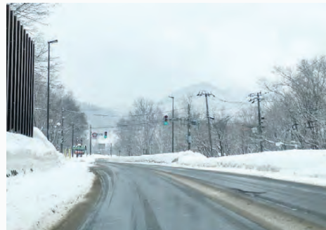
R230 定山溪 (照明柱)
