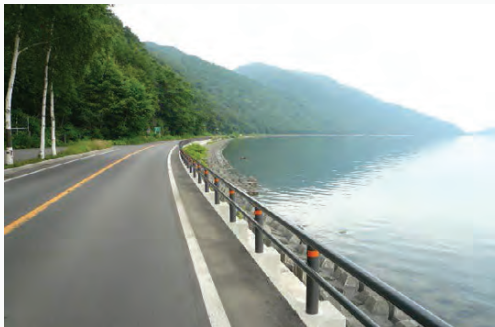
R453 支笏湖畔 (ガードパイプ)
