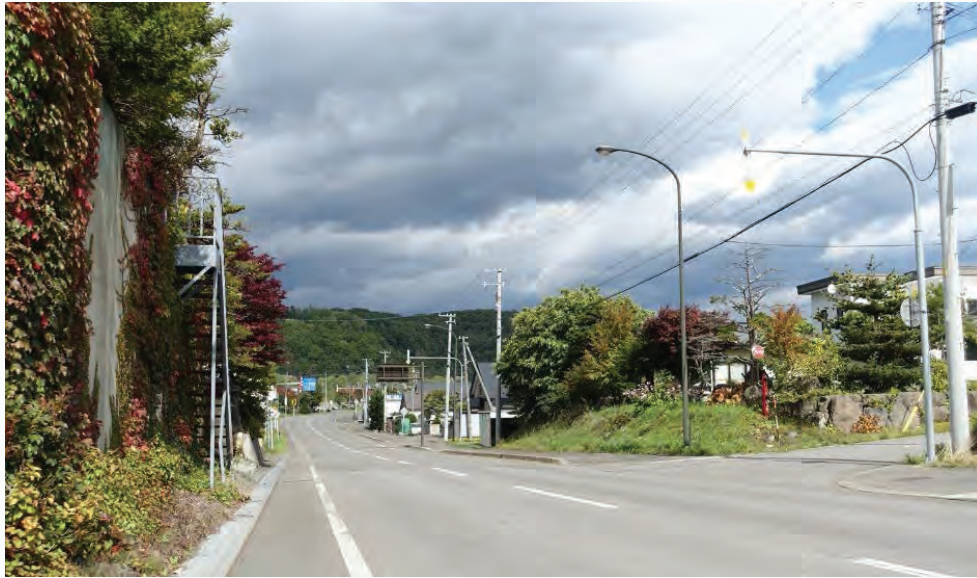
愛別町；道道140号の照明柱
