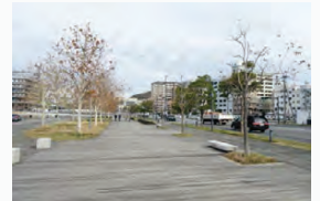
居心地のよい滞在空間となるよう空間を適切なスケールに区分する (長崎県長崎市)
