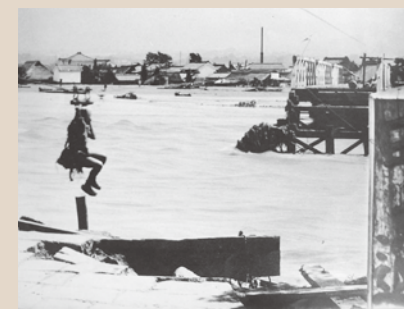
明治40年の大水害の状況 明治40年8月、県下を襲った台風は、死者233人、破壊・流失した家屋11,943戸の未曾有の大水害をもたらしました
