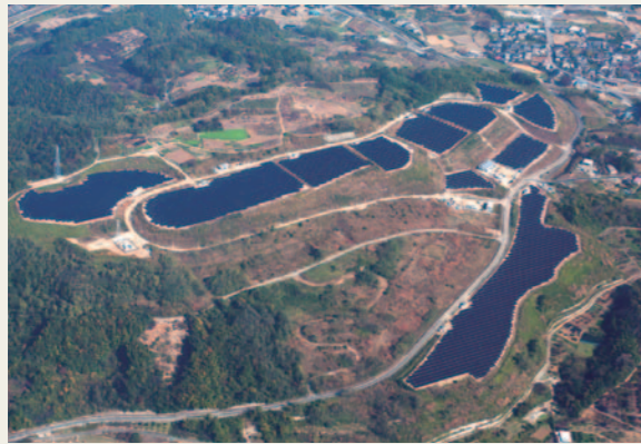
米倉山に敷き詰められた太陽光パネル
