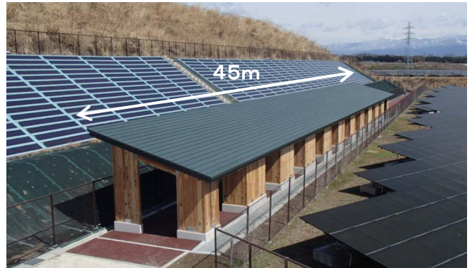
【サンシェードテラス(全体)】
