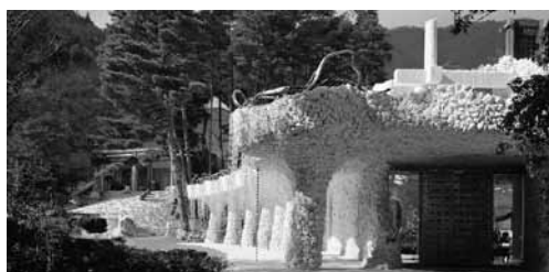
美術館全景（新館から本館望む）
