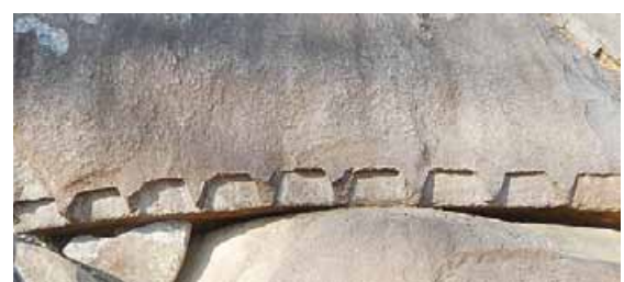
写真3 石垣の表面にみられる矢穴
