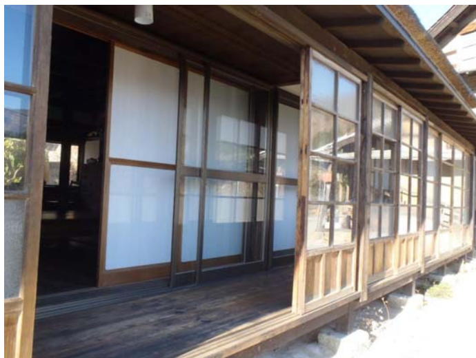
木製建具の内側にアルミサッシ 気密性を保ちつつ周囲の景観に配慮した
