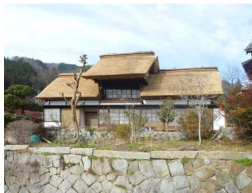
正面外観 アルミサッシが外部から見えない
