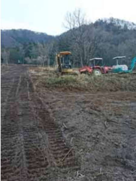
北ゾーン農地バンクでの原野の工事
