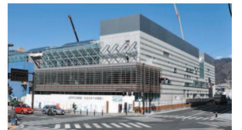
建設が進む新県立図書館（11月11日オープン予定）
