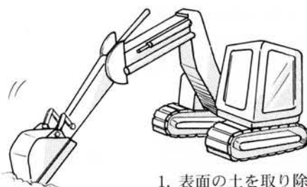
1. 表面の土を取り除く。土の層が厚い場合は重機をつかうことが多い。
