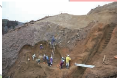
法面の調査のようす
