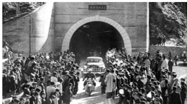
新笹子トンネル開通
