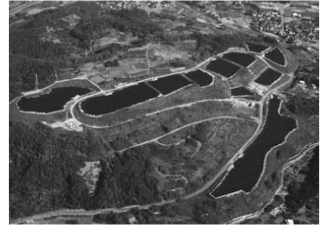
米倉山太陽光発電所
