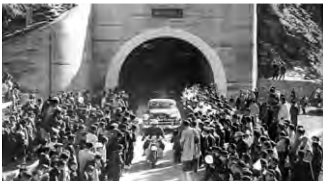
新笹子トンネル開通
