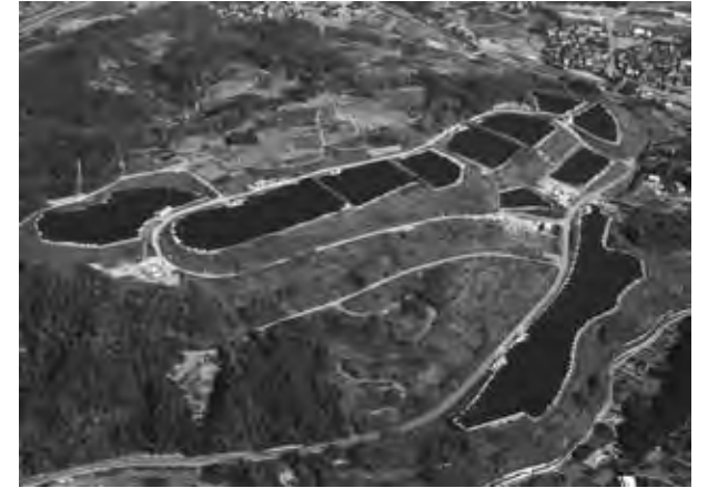
米倉山太陽光発電所
